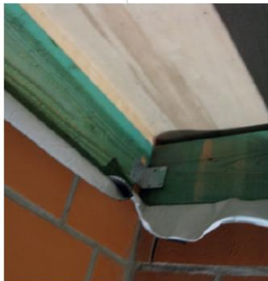
Afb. 2 en 3 Voorzien van een wachtfolie indien de draagbalken op het metselwerk opgelegd worden (de houten klossen tussen de draagbalken kunnen eventueel ook met metselwerk opgevuld worden).
